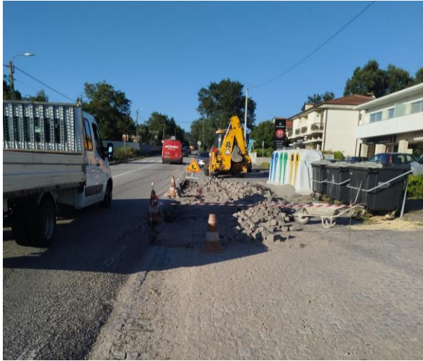
Figura 5: Reparação de bacia de estacionamento
