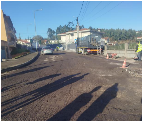
Figura 3: Repavimentação da Rua de Codeçoço
