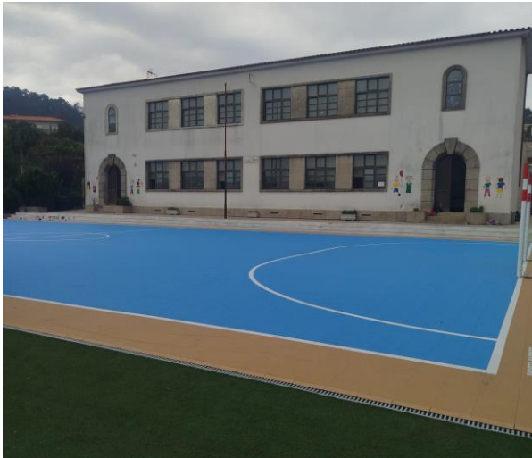
Figura 9: Instalação de novo piso na EB
