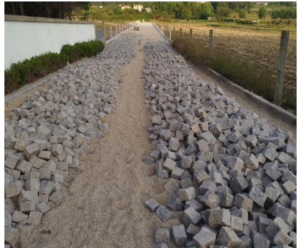
Figura 2: Repavimentação da Rua do Paço
