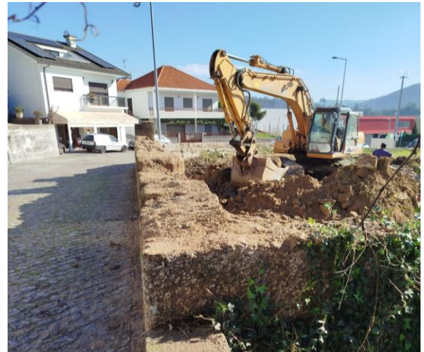
Figura 6: Demolição de habitação
